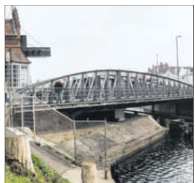
Weil die Hafendrehbrücke instand gesetzt wird, kommt es zu Verkehrsbehinderungen. Foto: Wese
